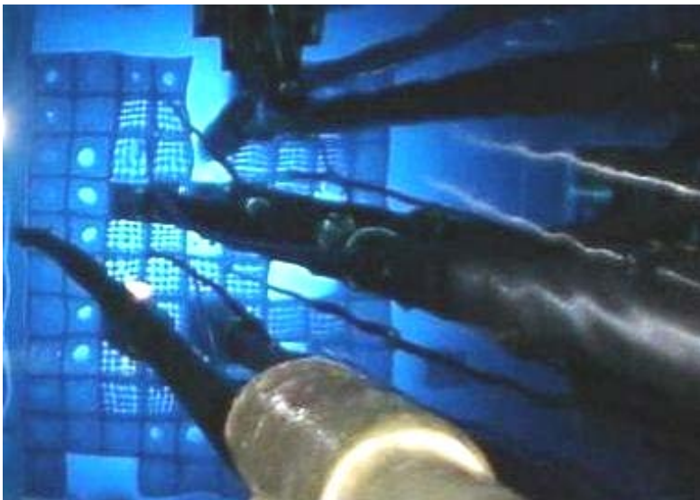
Zona activă a reactorului TRIGA SSR (14 MW) de concepție americană, cu un înalt grad de securitate, destinat pentru cercetări în regim staționar
